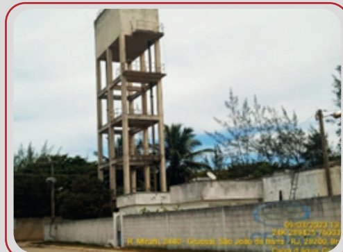
Sistema de abastecimento de água comunitário no município de São João da Barra/RJ.
