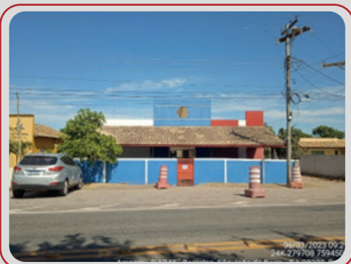
Escola Municipal da comunidade de Amparo.
