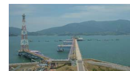
LNG wharf 1berth[80,000×1]
